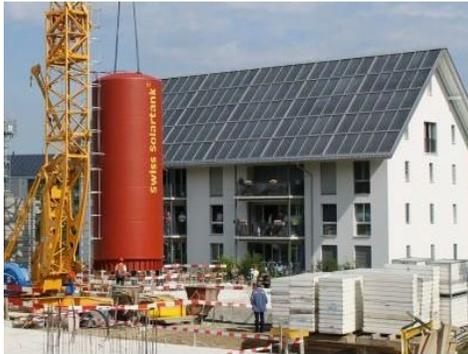
8-Familien-Sonnenhaus mit einer Kollektorfläche von 168 m<sup>2</sup> Solarwärme und 108 m<sup>3</sup> Wärmespeicher [Jenni Energietechnik AG]
