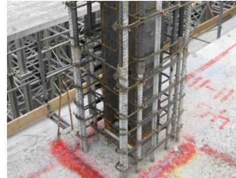
Stahl- / Betonverbundstütze
